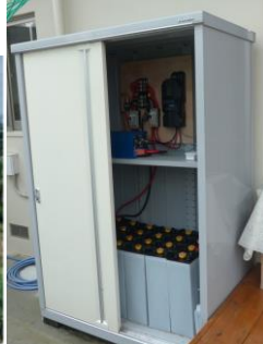
Hình 2 : 24 cục pin ắc quy khá to
