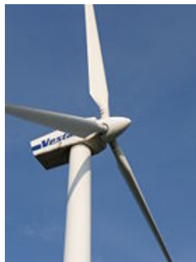
Hình 1: Turbine Gió Trục Ngang
